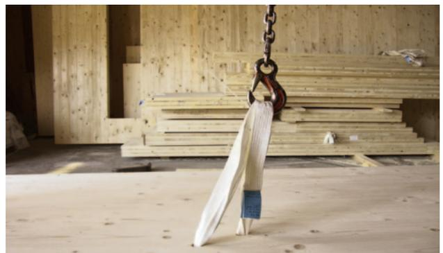
4. Situation de levage avec système Fd installé (distance entre les axes des perçages de 100 mm selon un angle de 45° par rapport au sens des fibres)
