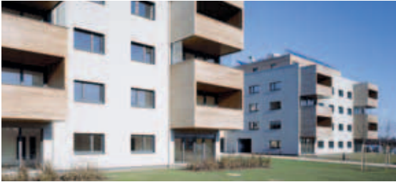
Immeuble passif « Am Mühlweg », Vienne
