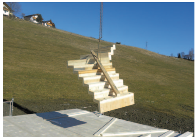
Fig. 48 - Montage d'un escalier préfabriqué
