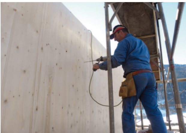
Fig. 39 à 42 - Montage des panneaux KLH®
