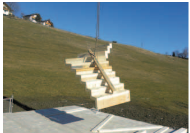
Fig. 48 - Montage d'un escalier préfabriqué
