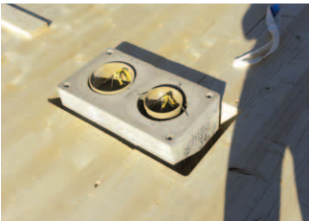
Fig. 47 - Montage d'une cheminée préfabriquée
