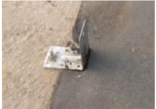
Fig. 37 - Pose de l'équerre de montage
