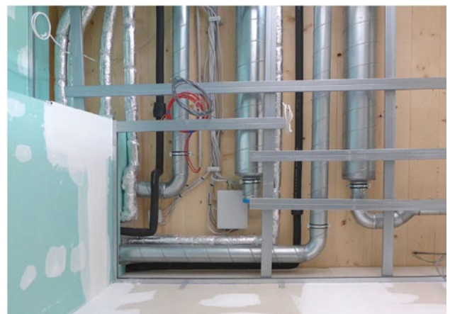
Fig. 69 - Passage de gaines dans le plafond suspendu
