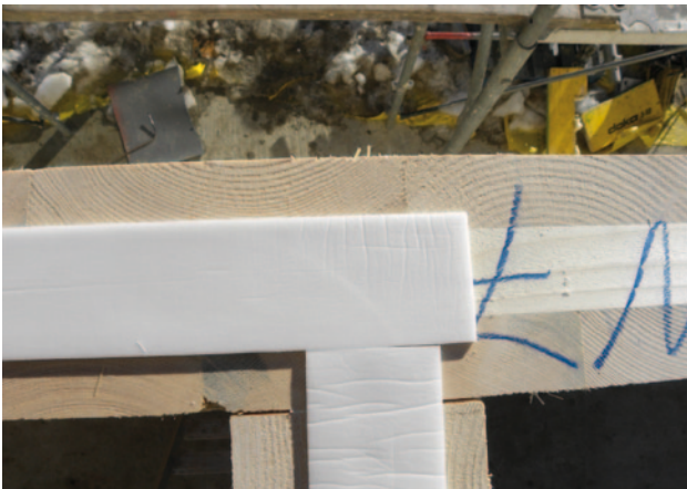
Fig. 12 - Ruban adhésif large (étanchéité à l'air)
