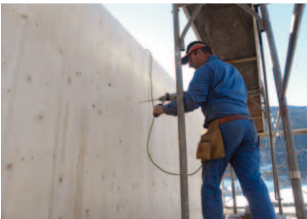
Fig. 39 à 42 - Montage des panneaux KLH®
