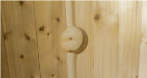
Fig. 50 - Fraisage des rainures pour les câbles
