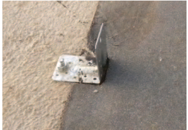
Fig. 37 - Pose de l'équerre de montage
