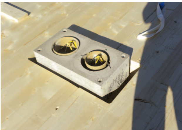
Fig. 47 - Montage d'une cheminée préfabriquée
