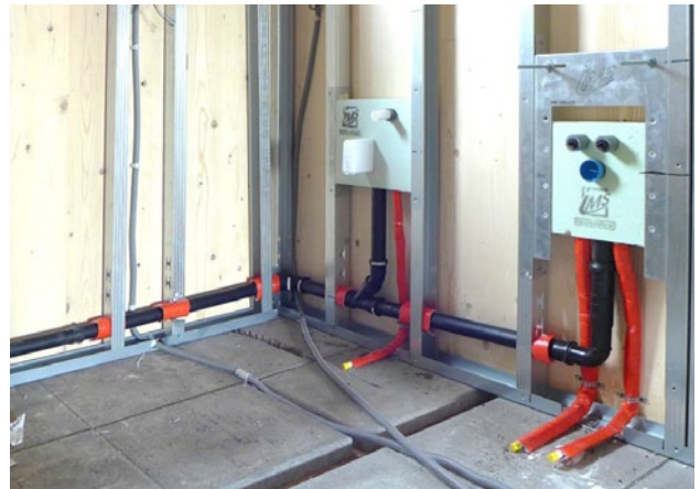
Fig. 65 - Passage des gaines dans le doublage du mur
