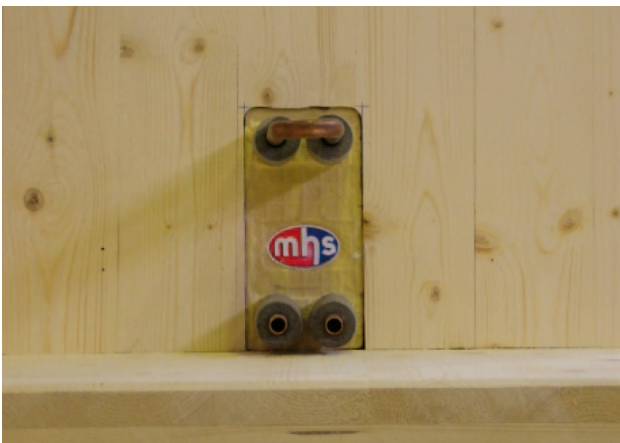
Montage du boîtier d'installation d'un radiateur à soupape
