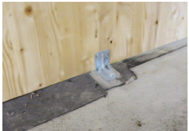
Fig. 38 - Coupure capillarité
