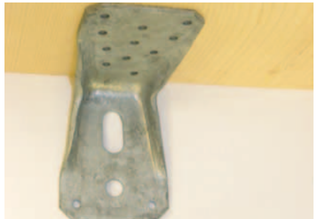
Fig. 11 - Équerre de montage
