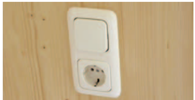
Fig. 54 - Installation d'une combinaison prise de courant/interrupteur sur des parois avec surface visible. Le trou du côté visible doit correspondre au diamètre de la prise ou au cadre de recouvrement (généralement 68 de diamètre)
