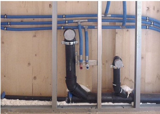
Fig. 64 - Passage des gaines dans le doublage du mur
