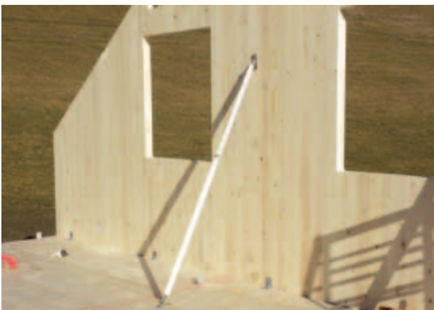
Fig. 43 à 46 - Montage des panneaux contrecollés KLH®
