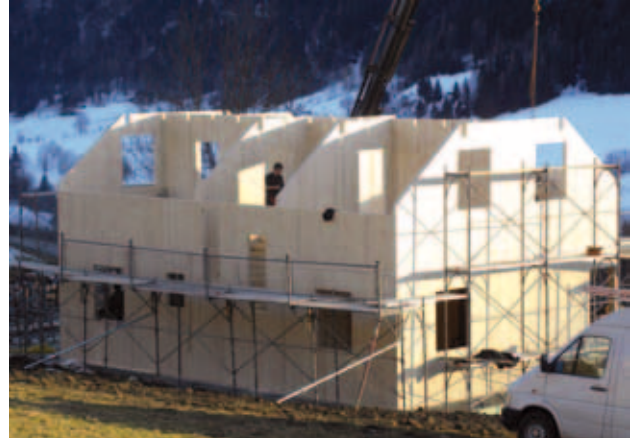
Fig. 4 - Échafaudage de montage
