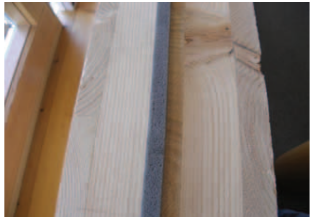
Fig. 13 - Ruban adhésif étroit (étanchéité à l'air)
