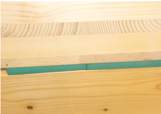
Fig. 14 - Appui élastomère (résilient acoustique)
