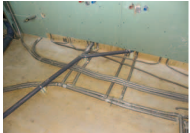
Fig. 65 - Raccordement d'un lavabo double
