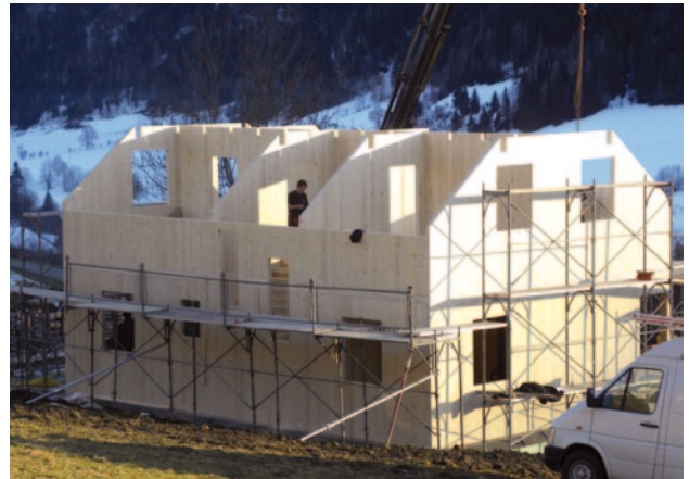
Fig. 4 - Échafaudage de montage
