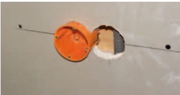
Fig. 52 - Pose des panneaux de placoplâtre type F par le plaquiste dans le cadre du perçage des prises
