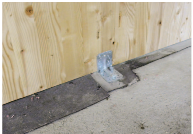
Fig. 38 - Coupure capillarité
