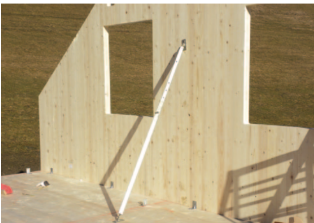
Fig. 43 à 46 - Montage des panneaux contrecollés KLH®
