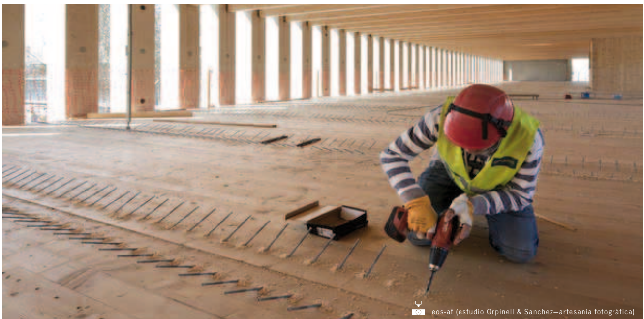
Réalisation des liaisons transversales
