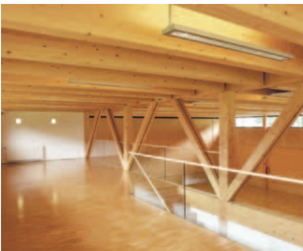
Mise en œuvre d'éléments KLH® nervurés dans une salle de spectacle
