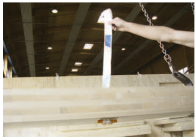
4. Levage avec système FB incorporé
