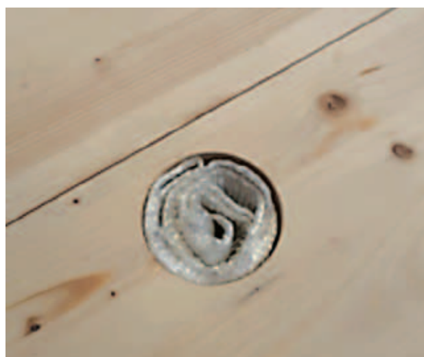
3. Sangle enroulée dans la réservation pour le transport
